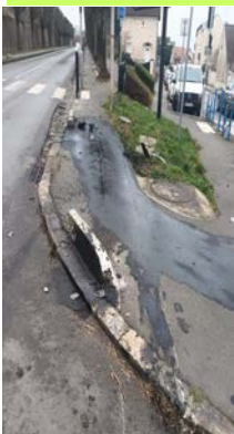
Av. de la gare Avant
