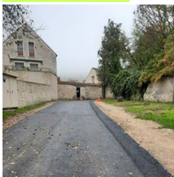
Réfection rue de l'Esnonne
