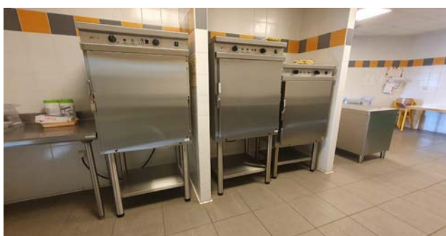
Installation nouveau four au restaurant scolaire
